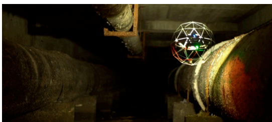
Figura 4. Tecnología Dron para la inspección de redes
