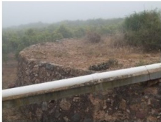
Estado actual de la plataforma de la Noria, se mantiene gran parte de la estructura original, mampostería doble de piedra
