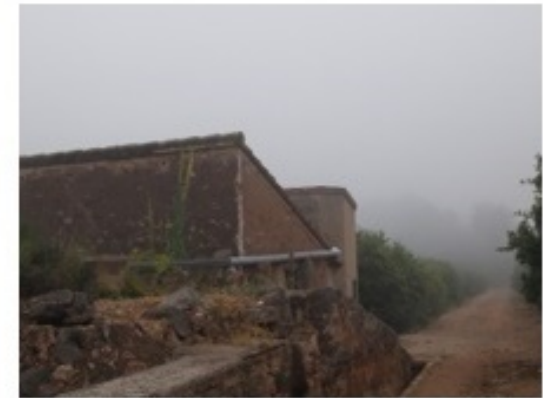
Estructuras recientes que muestran el uso de tecnologías actuales (bomba sumergible), la tubería conduce el agua del nuevo pozo a la balsa.
