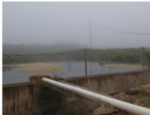
Balsa construida posteriormente, lo cual se evidencia por la cota de descarga de la tubería.
