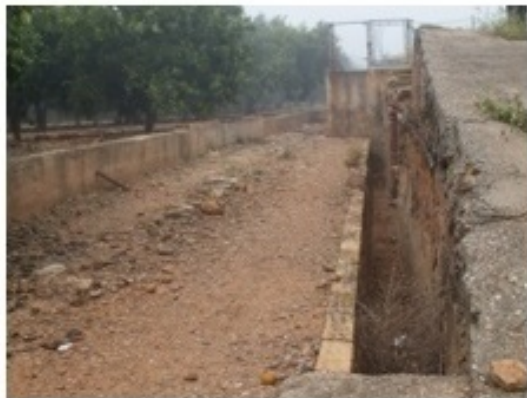
Acá se puede apreciar como el sistema original descargaba directamente a la acequia.
