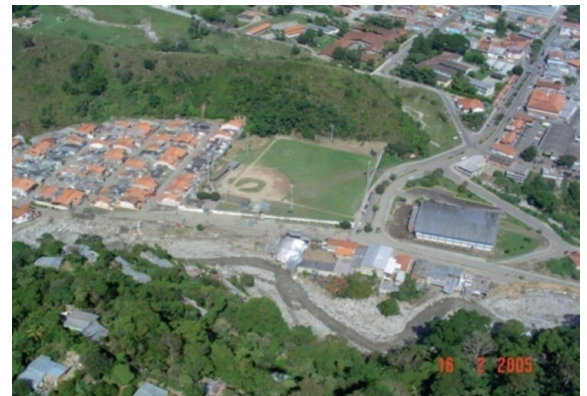
Figura 15. La elipse segmentada en color amarillo muestra una de los tramos impactados por el río Mocotíes durante el evento de febrero de 2005, en parte del sector la Vega. Nótese además los daños sobre la vialidad (en flechas color negro). Imagen cortesía de la Guardia Nacional Bolivariana y la Aviación Militar Bolivariana, pertenecientes al vuelo en helicóptero del 16/02/2005)
